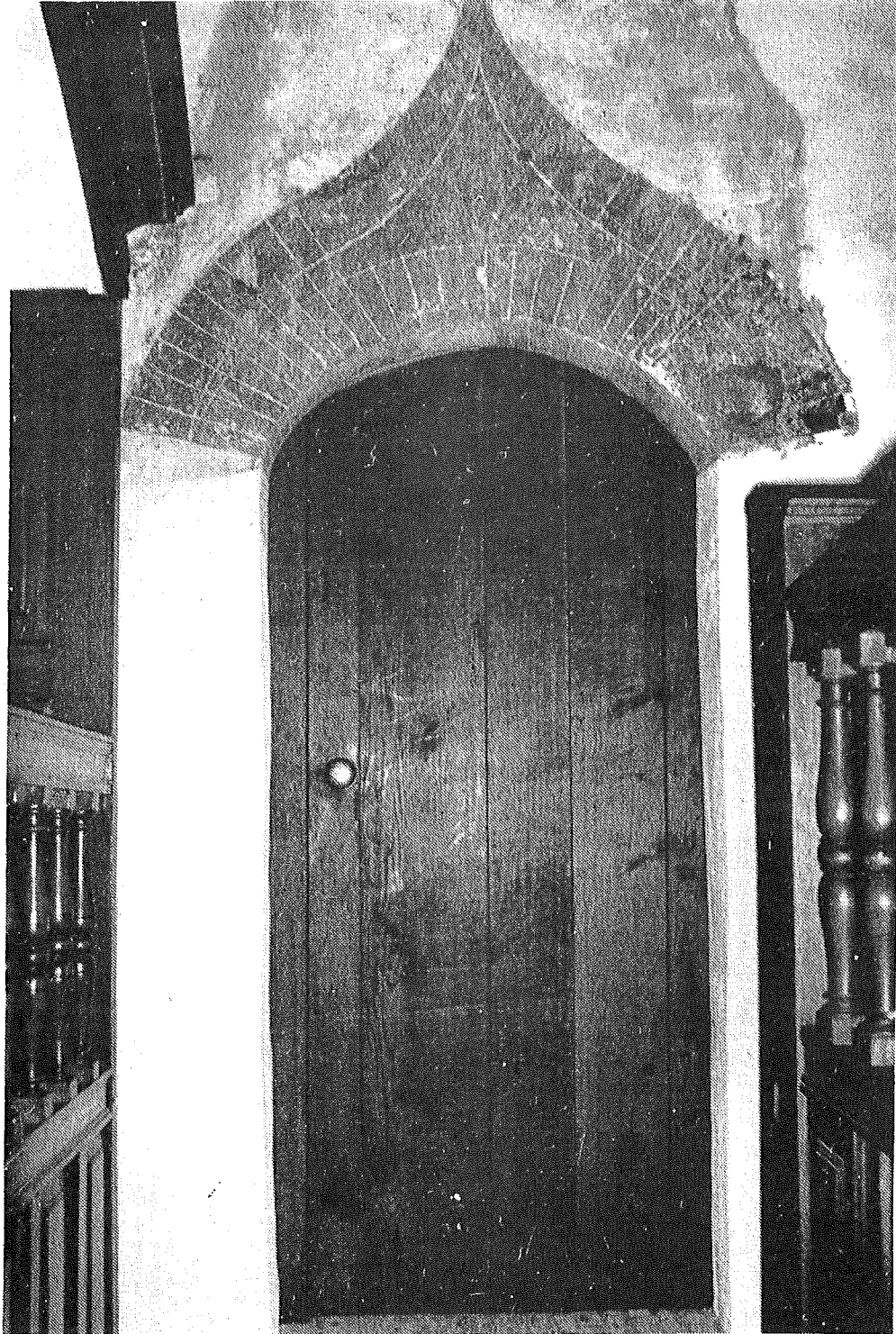
Voormalige doorgang naar de uitbouw noordzijde, thans nooduitgang. Tevens hierboven restant muurschildering.
